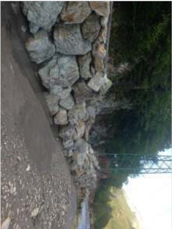
Vista Strada Comunale di Sparvaïra–Intervento n°11
