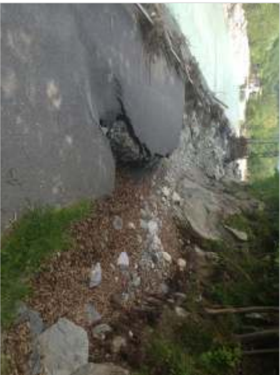
Vista Strada Comunale di Sparvaïra–Intervento n°12
