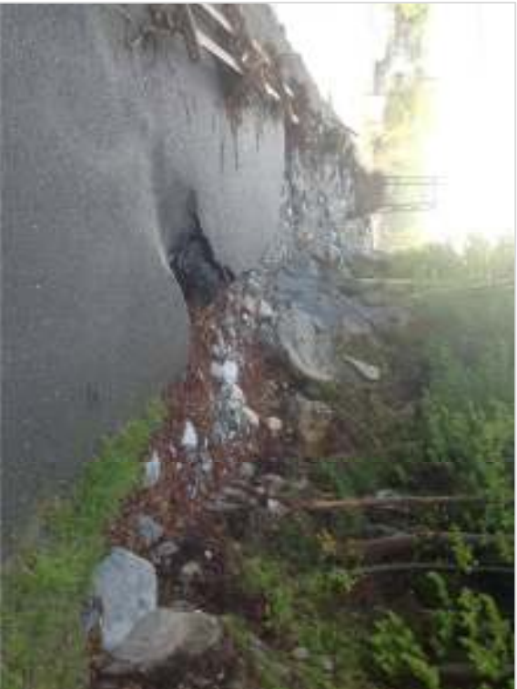
Vista Strada Comunale di Sparvaïra–Intervento n°12
